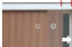
扉の開きが50mm以上の部分では消音ダンパー機能は働きません。開きが50mm以下になった所から静かに扉を引き込みます。
